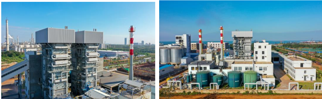
图 24 生物质发电锅炉及燃烧系统
